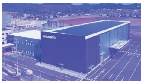
太陽光発電により消費電力を抑制した当社新工場
